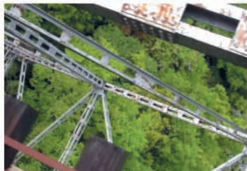
▲高さ100mの関ノ沢橋梁に目がくらむ。
